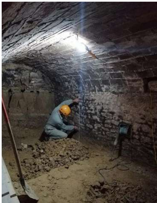
restauro della grotta dicembre 2022
